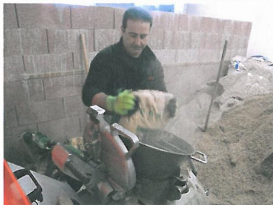
Bild 4: Einfüllen des Zements für die Standardestrichmischung
